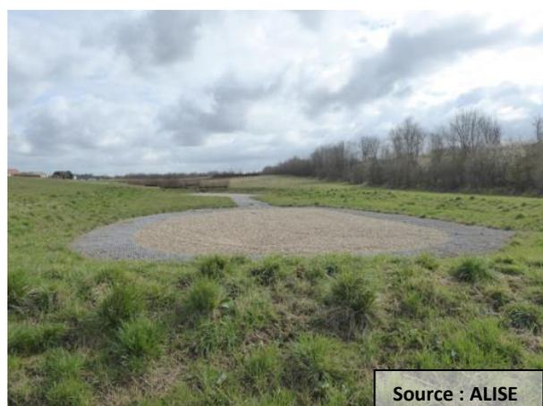
Photo 13 Zone d'infiltration (bétouilles) au niveau du cimetière
