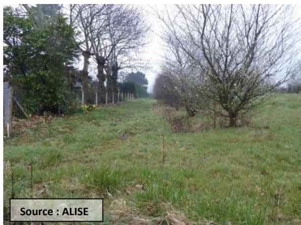
Photo 46 Fossé canalisant les eaux de ruissellement
